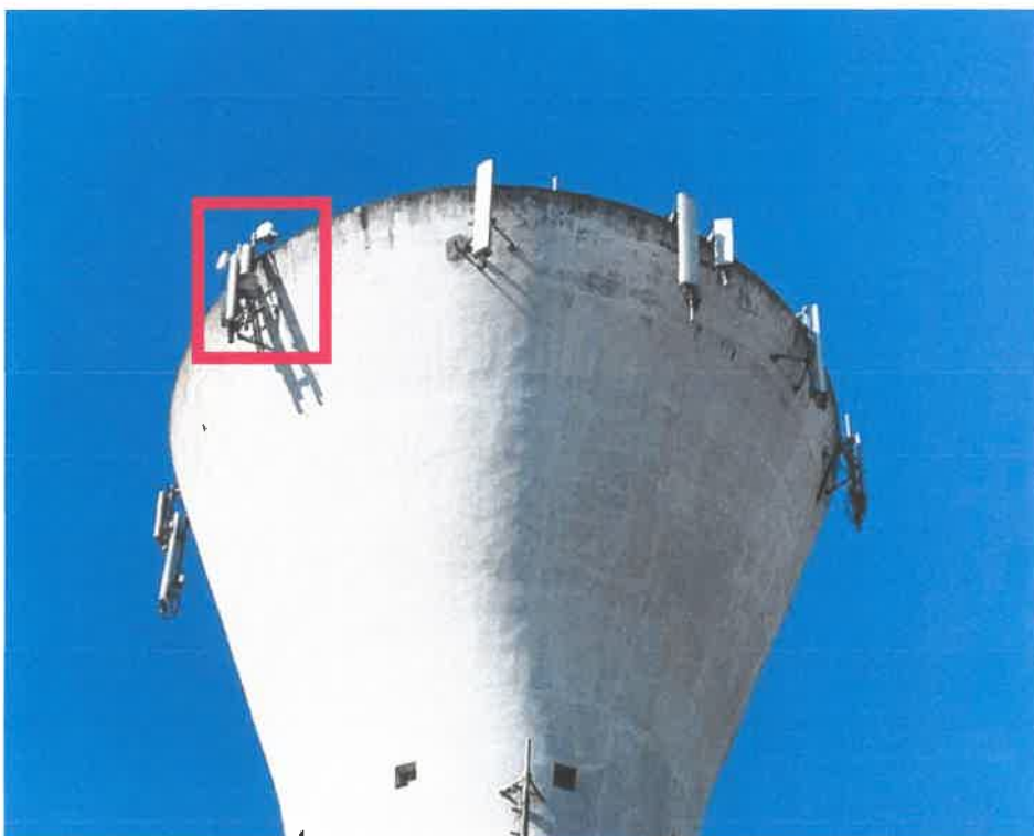
Vue de la terrasse S1 après travaux
