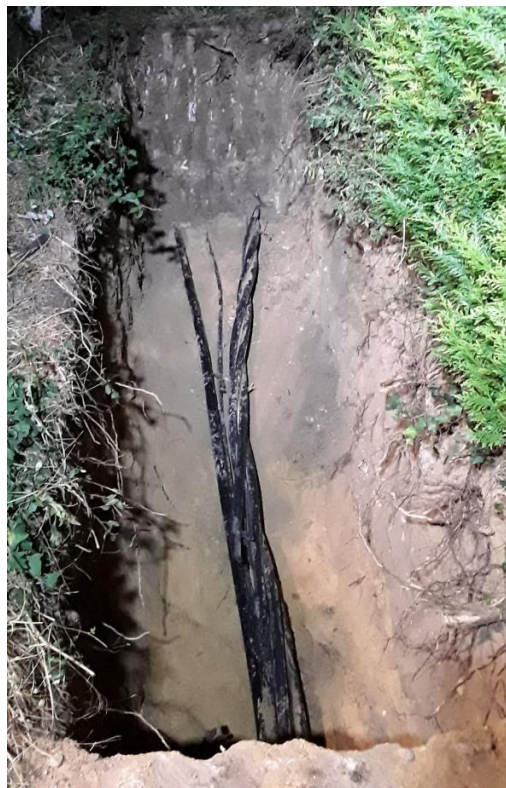
Tranchées ouvertes pour la réparation du câble sente des Vergers à Mézy-sur-Seine
