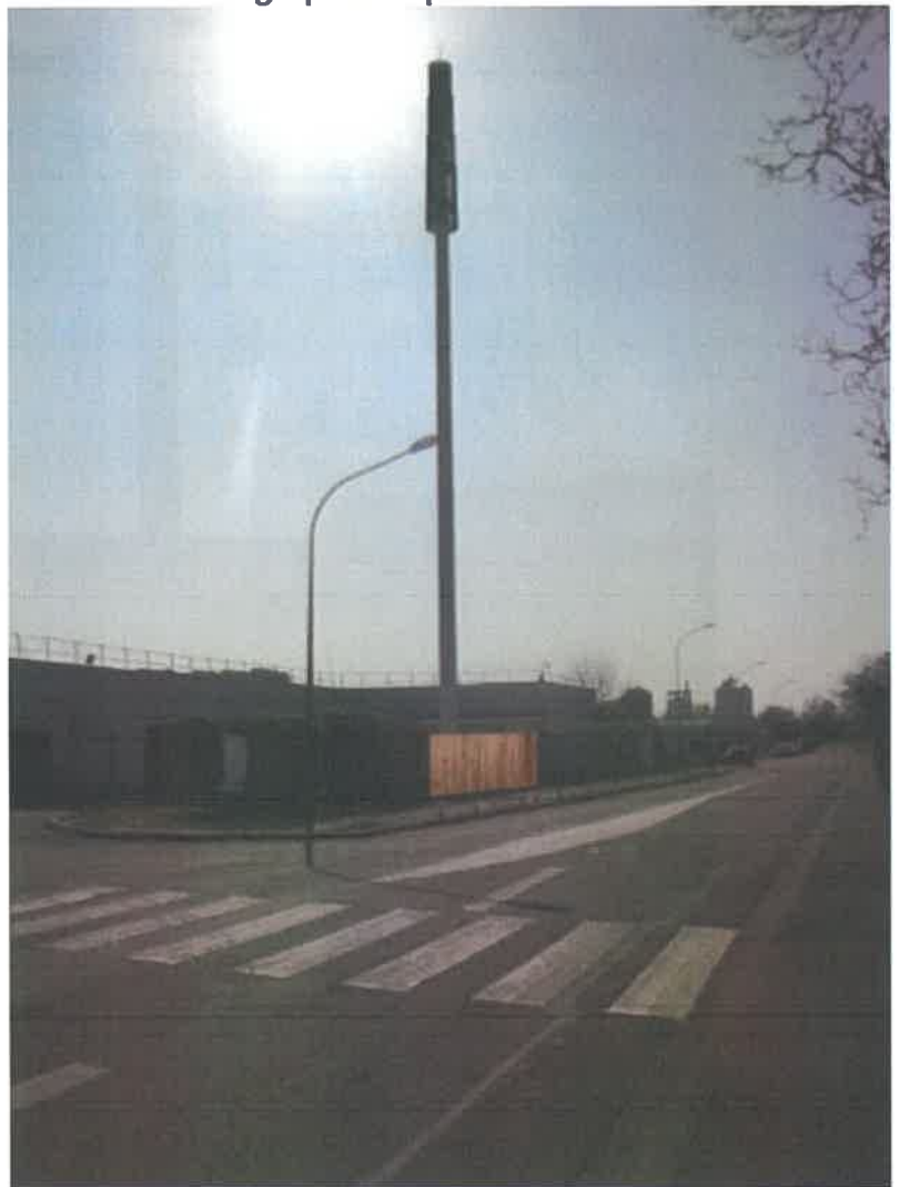
Photographie 2 après travaux
